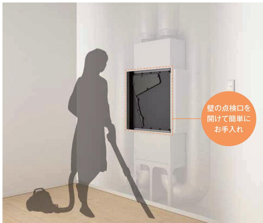
換気ユニットを壁内設置することで、高性能フィルターや防虫ネットのお手入れがラクラク。脚立などに乗って作業する必要がなく、手が届く高さで安全に行えます。また、運転操作は壁スイッチのみで簡単です。
